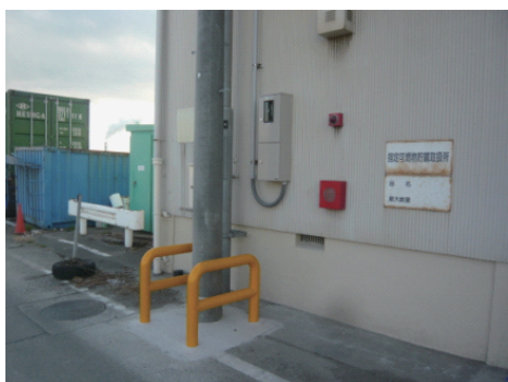
ガードパイプ
